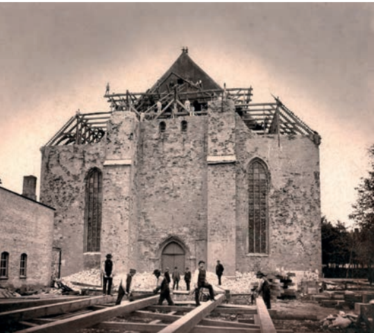
Die Arbeiten am Dom starteten am 2. August 1888 mit dem langsamen Abbruch von Westjoch und Westgiebel.
